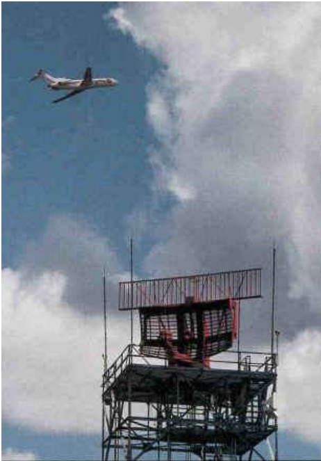
↑ kombinált hagyományos elsődleges és másodlagos radarok (PSR + SSR)
